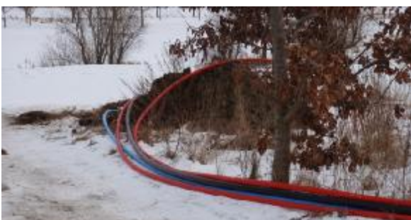
150m rør skal trækkes tilbage mellem hullerne
